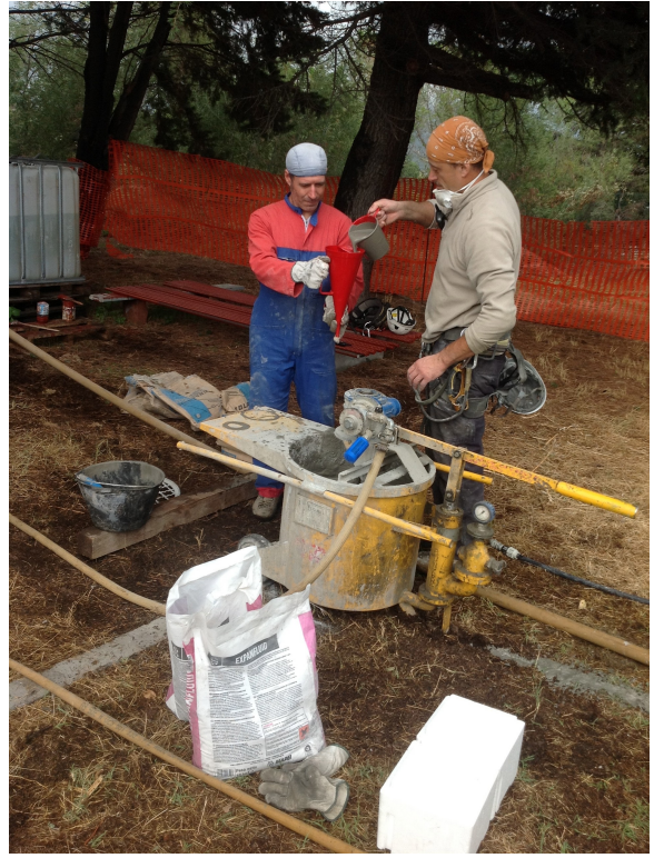
Controllo fluidità miscela d'iniezione
