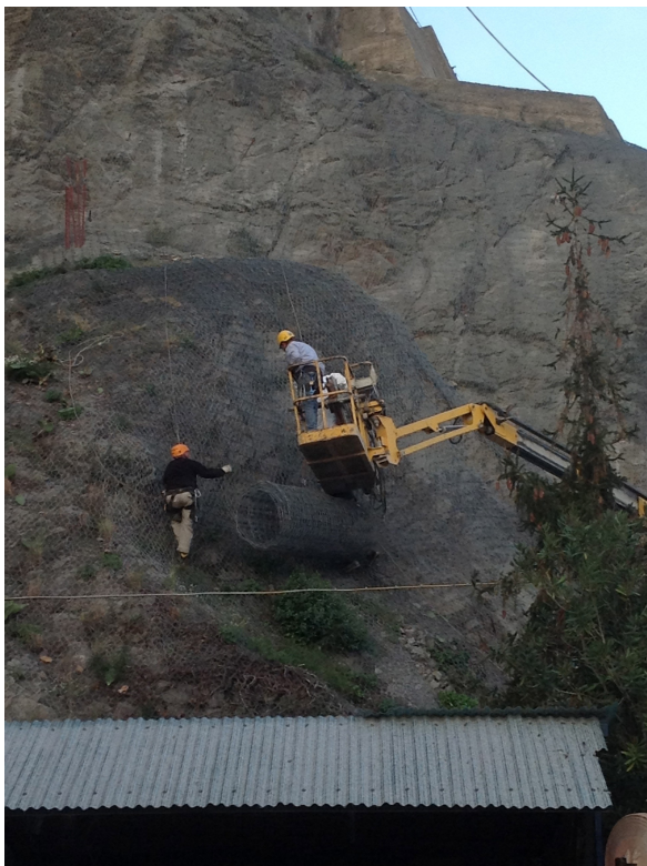
Posa in opera reti di rivestimento
