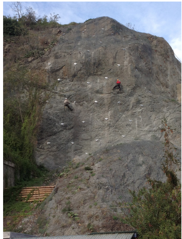
Posa e serraggio piastre di ancoraggio
