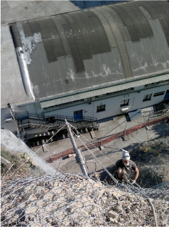
Fasi di perforazione in parete
